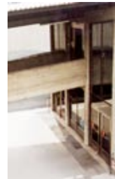
Ramp och portal Telefonplan
