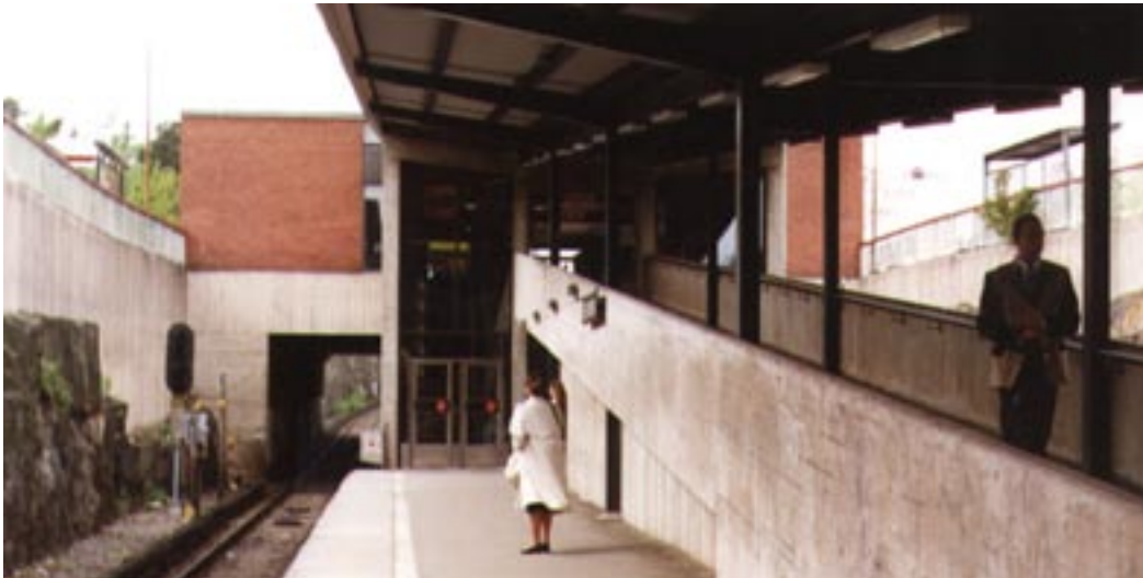
Ramp och portal Telefonplan
